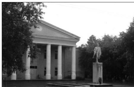
Здание районного Дома культуры
