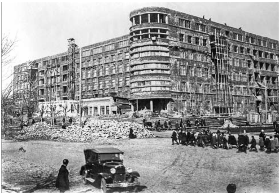
27. Строительство здания Запсибкрайисполкома. 1932 г.
