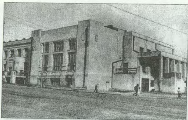
Здание фабрики акционерного общества «Киносибирь». (фот. 1930 г.)
