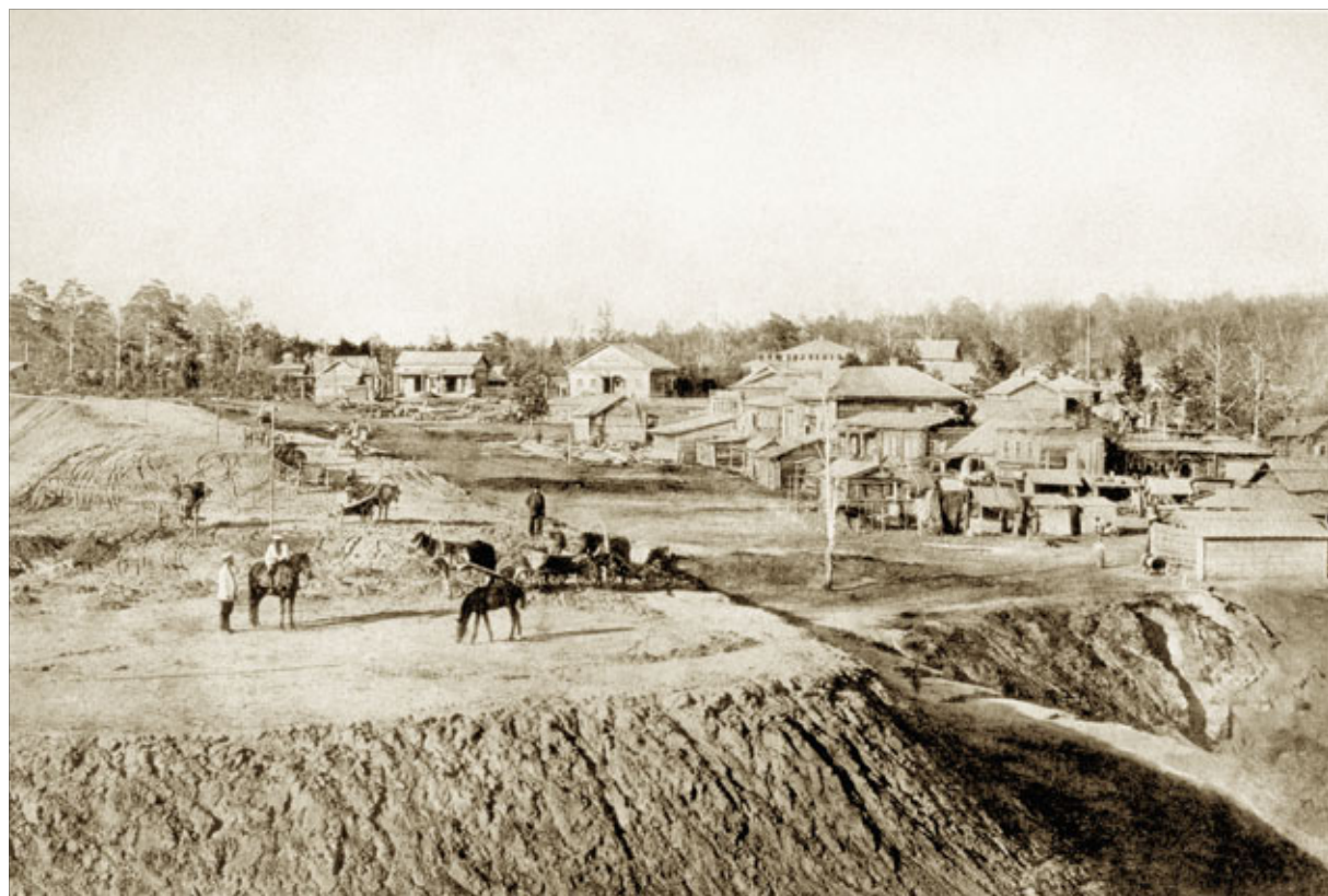
23. Работы по строительству железной дороги и моста через р. Обь, 1893–1894 гг.
