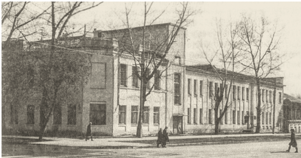
79. Здание школы № 29 на ул. Серебренниковской
